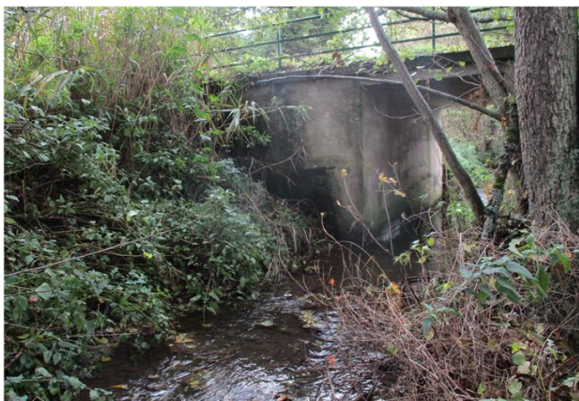
Foto gegen Fließrichtung
