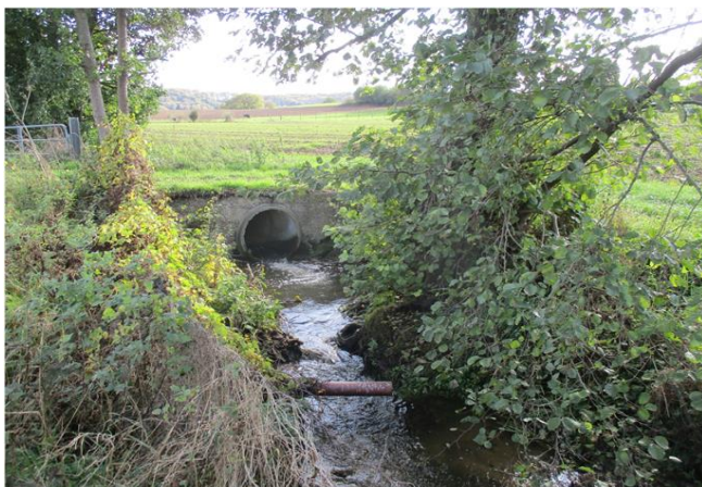
Foto gegen Fließrichtung
