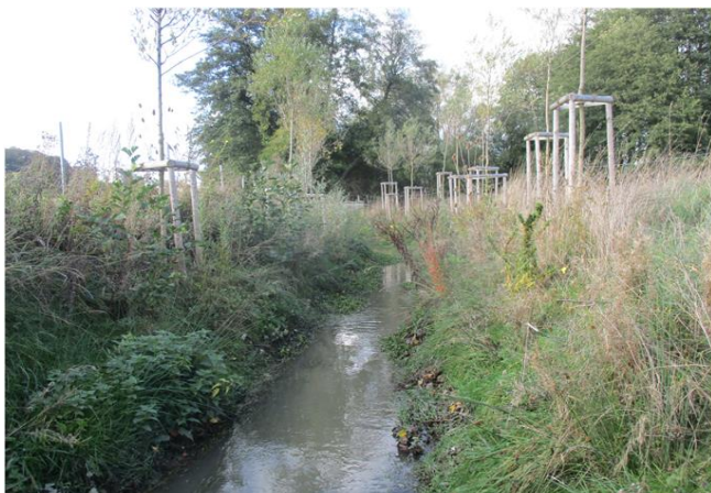
Foto gegen Fließrichtung
