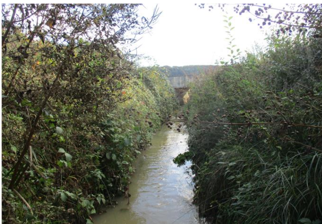
Foto gegen Fließrichtung
