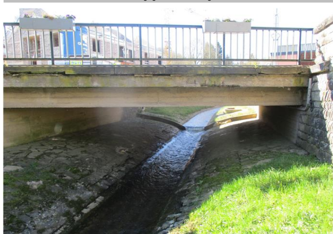
Foto gegen Fließrichtung
