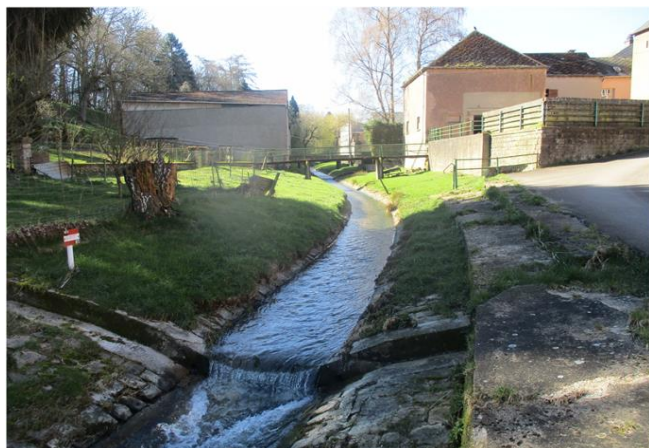
Foto gegen Fließrichtung
