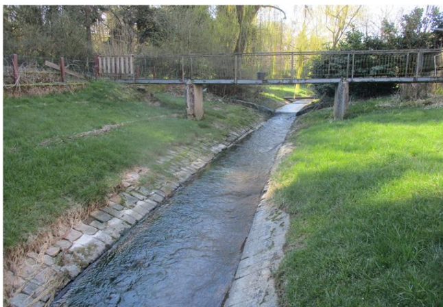
Foto gegen Fließrichtung
