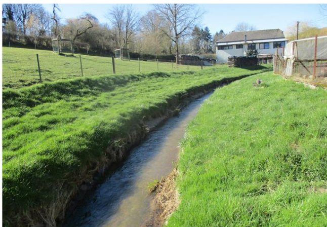
Foto gegen Fließrichtung
