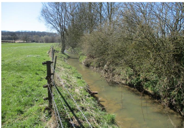
Foto gegen Fließrichtung
