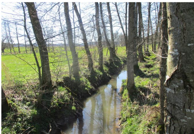
Foto gegen Fließrichtung
