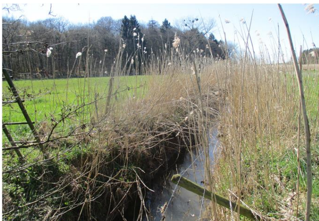
Foto gegen Fließrichtung
