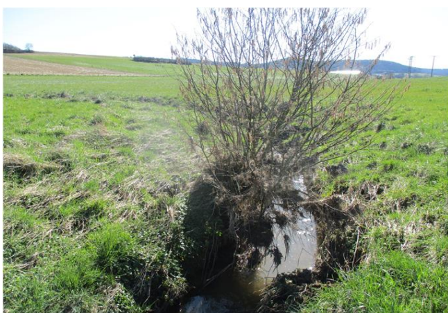
Foto gegen Fließrichtung
