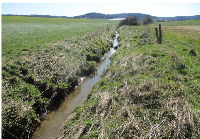
Foto gegen Fließrichtung
