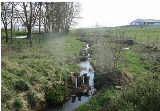
Foto gegen Fließrichtung
