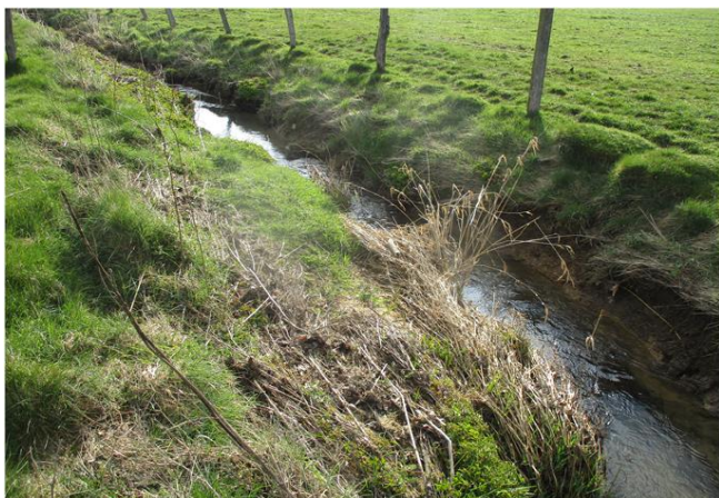
Foto gegen Fließrichtung
