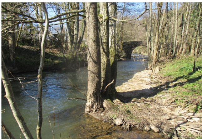
Foto gegen Fließrichtung
