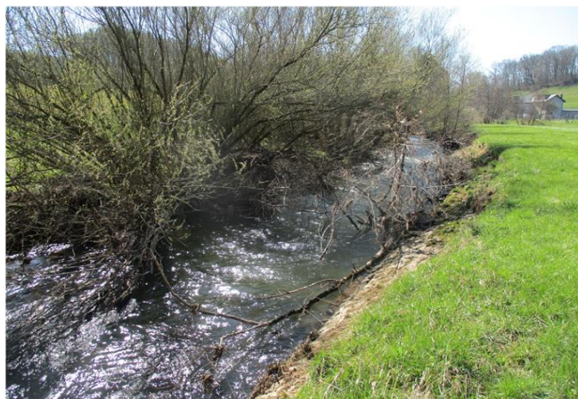
Foto gegen Fließrichtung
