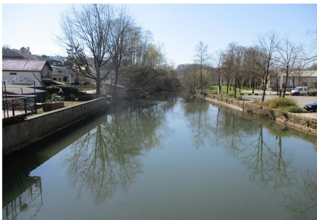
Foto gegen Fließrichtung
