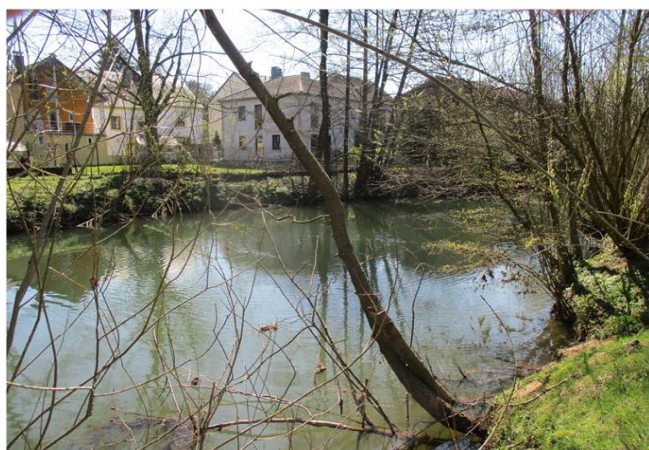
Foto gegen Fließrichtung
