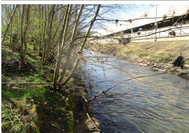
Foto gegen Fließrichtung
