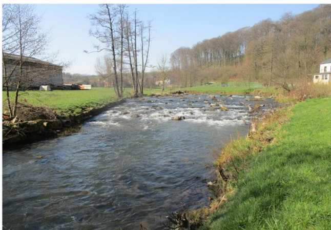
Foto gegen Fließrichtung
