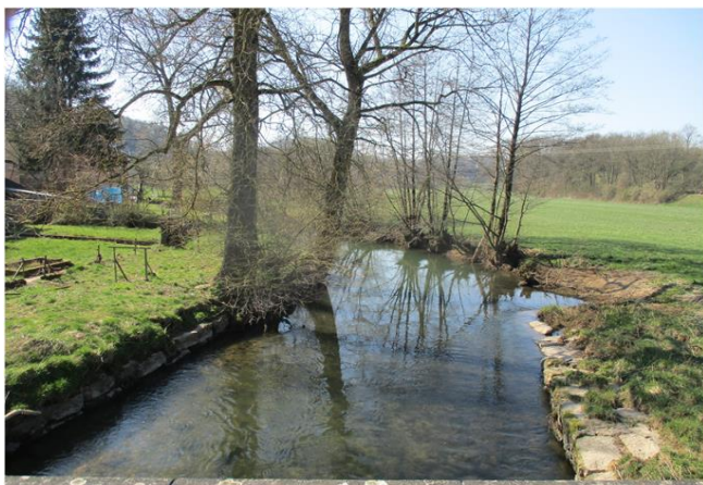
Foto gegen Fließrichtung
