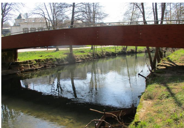
Foto gegen Fließrichtung
