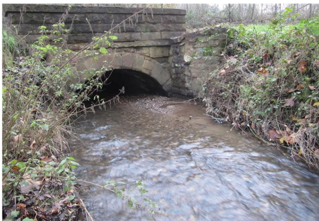
Foto gegen Fließrichtung
