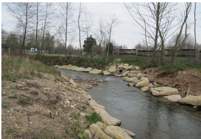
Foto gegen Fließrichtung
