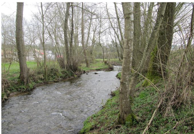
Foto gegen Fließrichtung
