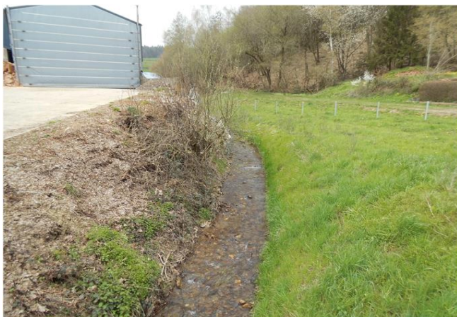
Foto gegen Fließrichtung
