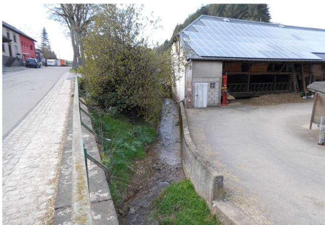
Foto gegen Fließrichtung
