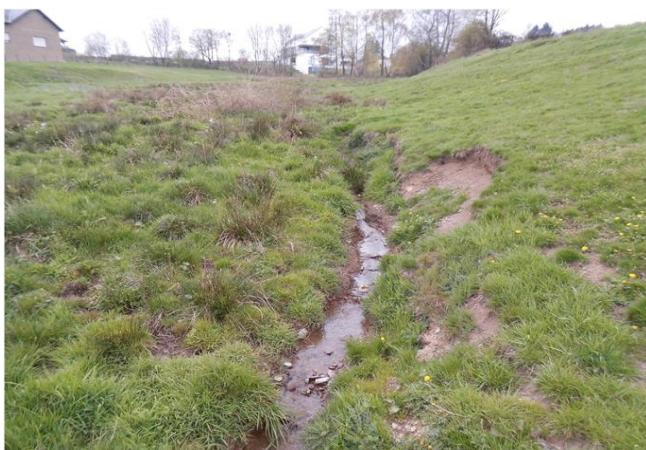
Foto gegen Fließrichtung
