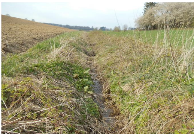
Foto gegen Fließrichtung
