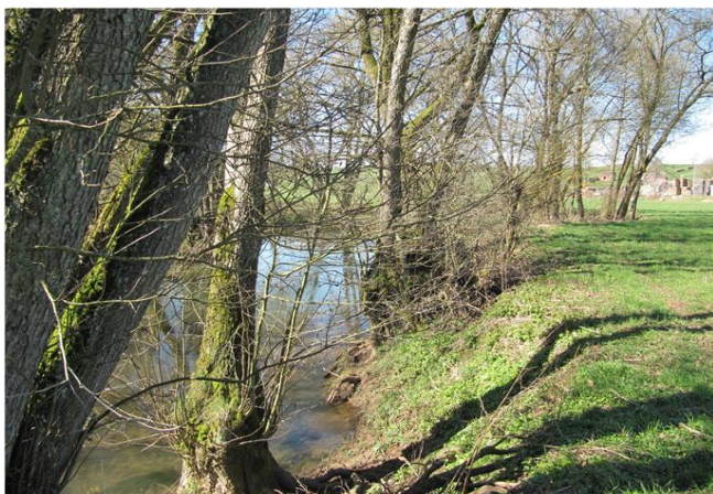
Foto gegen Fließrichtung
