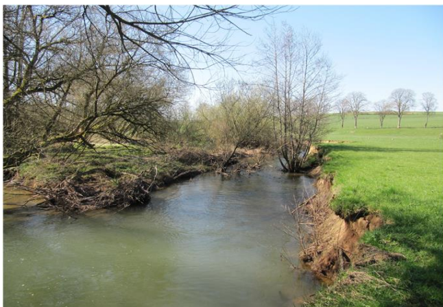
Foto gegen Fließrichtung
