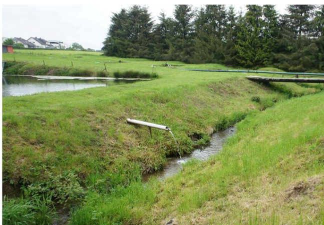
Foto gegen Fließrichtung
