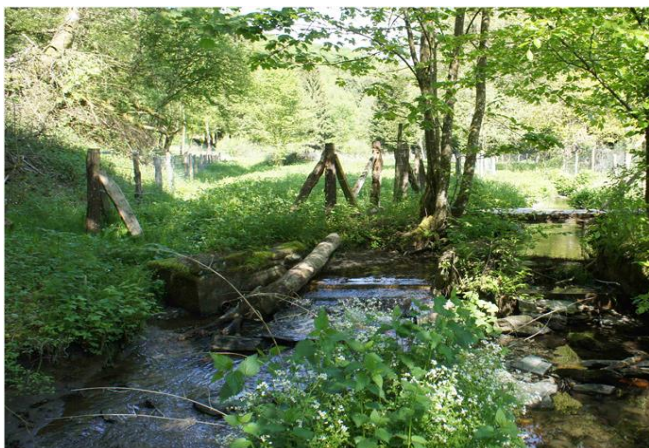
Foto gegen Fließrichtung
