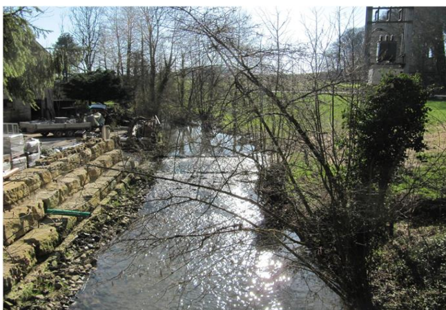
Foto gegen Fließrichtung
