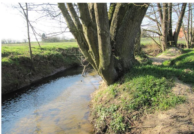
Foto gegen Fließrichtung
