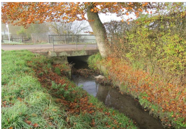
Foto gegen Fließrichtung
