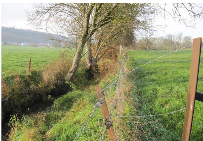
Foto gegen Fließrichtung
