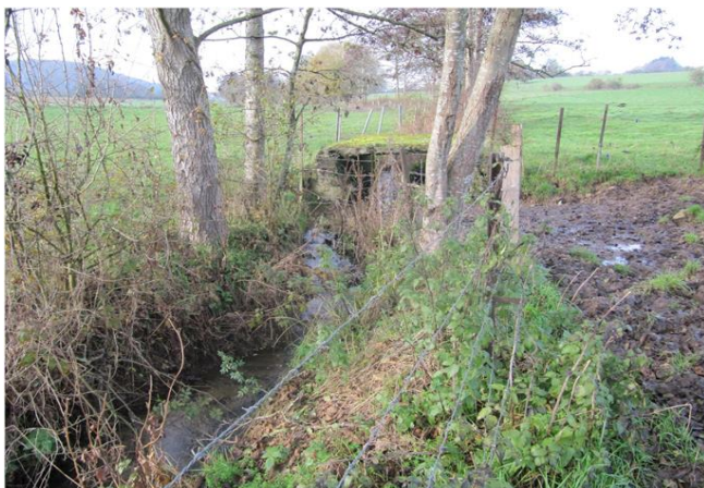
Foto gegen Fließrichtung
