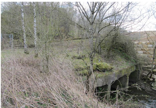
Foto gegen Fließrichtung
