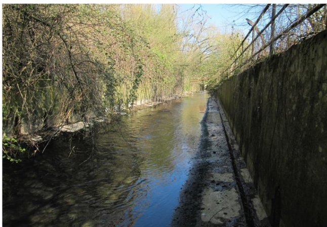
Foto gegen Fließrichtung
