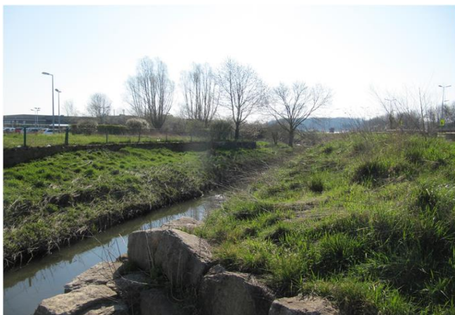
Foto gegen Fließrichtung
