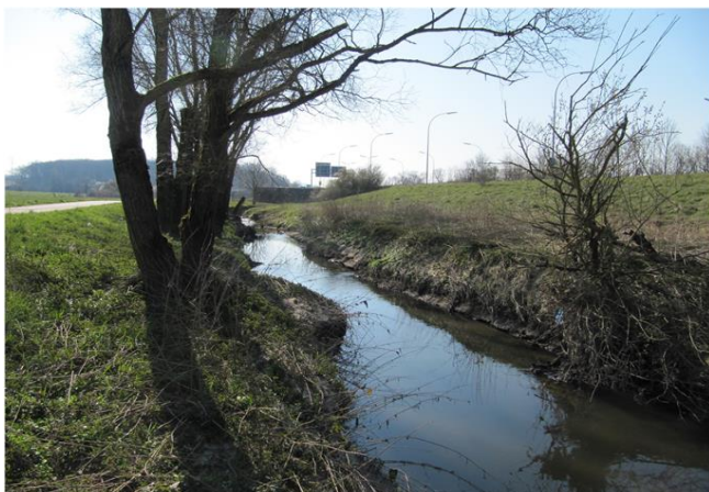
Foto gegen Fließrichtung
