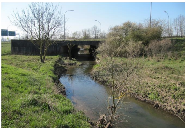
Foto gegen Fließrichtung
