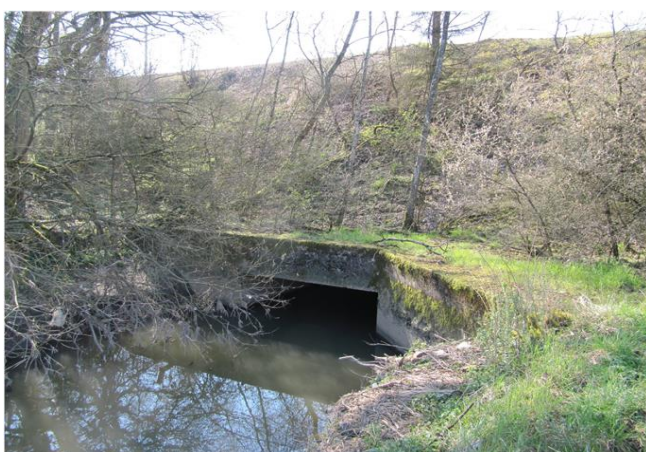
Foto gegen Fließrichtung
