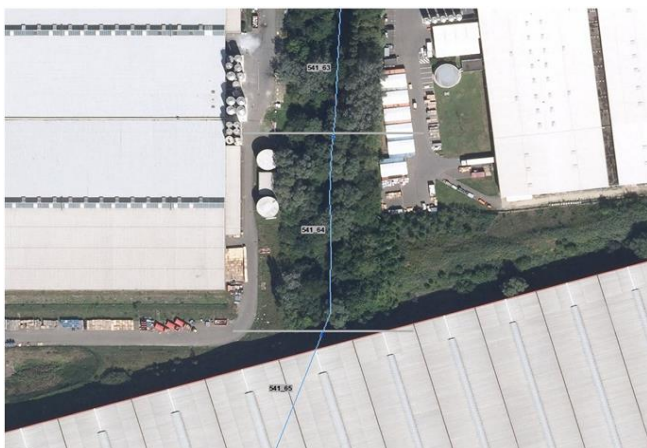
Foto gegen Fließrichtung
