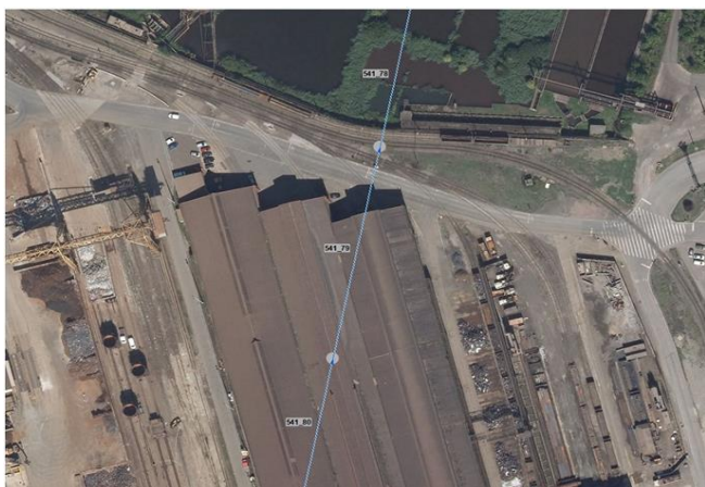
Foto gegen Fließrichtung
