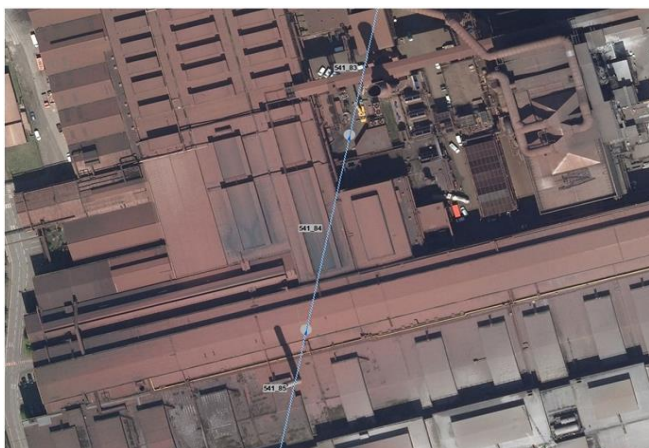
Foto gegen Fließrichtung
