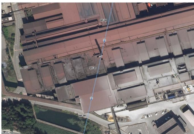
Foto gegen Fließrichtung
