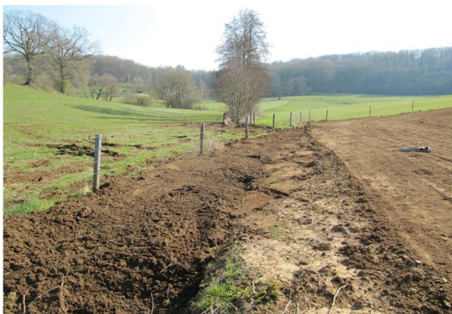
Foto gegen Fließrichtung
